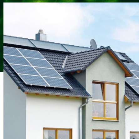
MODUŁY I INWERTERY FOTOWOLTAICZNE
