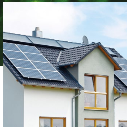
MODUŁY I INWERTERY FOTOWOLTAICZNE
